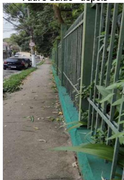
Figura 50: poda externa ao gradil - Rua Padre Guido - depois
