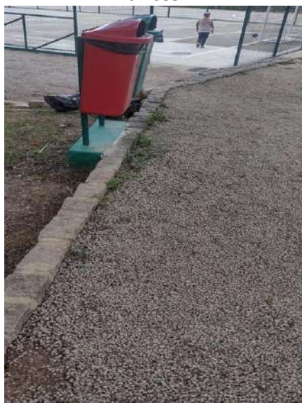
Figura 65: Despraguejamento de áreas comuns - lateral as quadras/portaria 2 - antes
