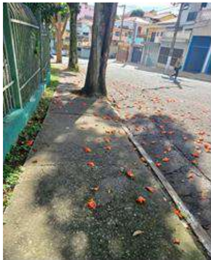
Figura 136: limpeza externa de calçadas - antes
