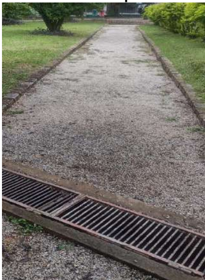
Figura 59: Despraguejamento de áreas comuns - lateral as quadras - antes
