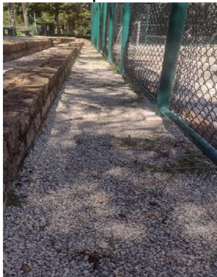
Figura 63: Despraguejamento de áreas comuns - arquibancada - antes
