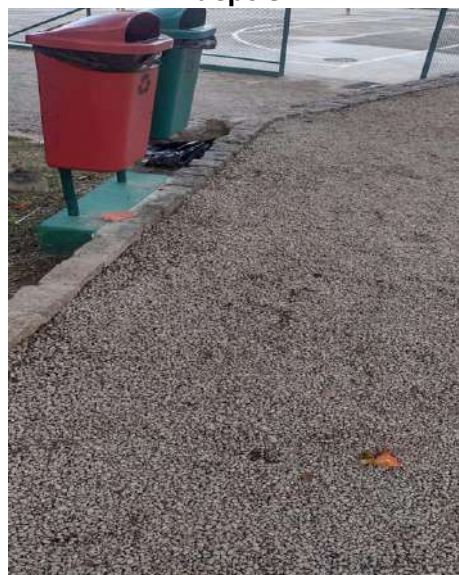
Figura 66: Despraguejamento de áreas comuns - lateral as quadras/portaria 2 - depois
