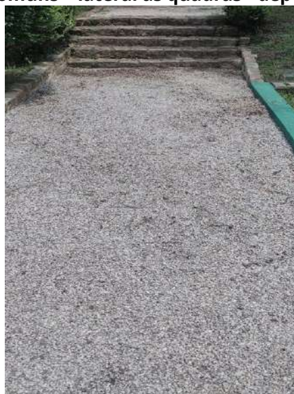
Figura 62: Despraguejamento de áreas comuns - lateral as quadras - depois
