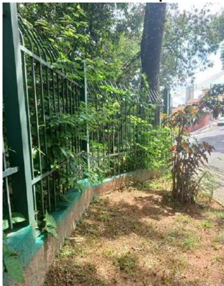
Figura 53: poda externa ao gradil – Rua Laudelino Vieira de Campos - antes
