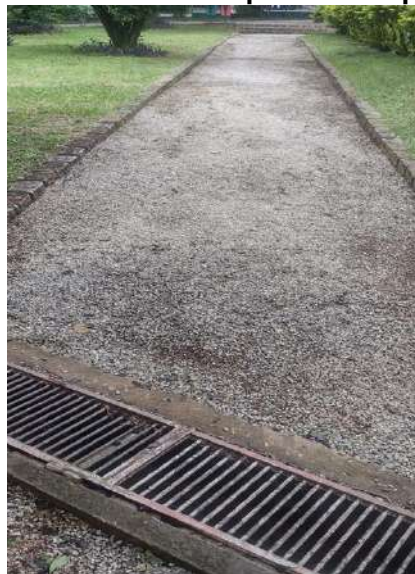
Figura 60: Despraguejamento de áreas comuns - lateral as quadras - depois
